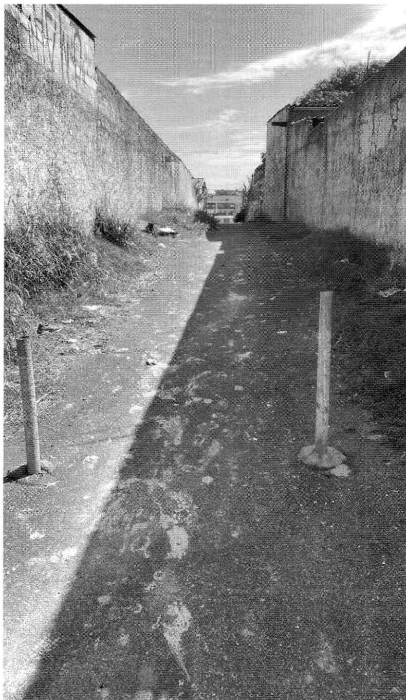
ILUMINAÇÃO PÚBLICA NA TRAVESSA RUA QUINZE DE AGOSTO, NA ALTURA DO Nº 30 - JARDIM AEROPORTO 3 – MOGI DAS CRUZES.
